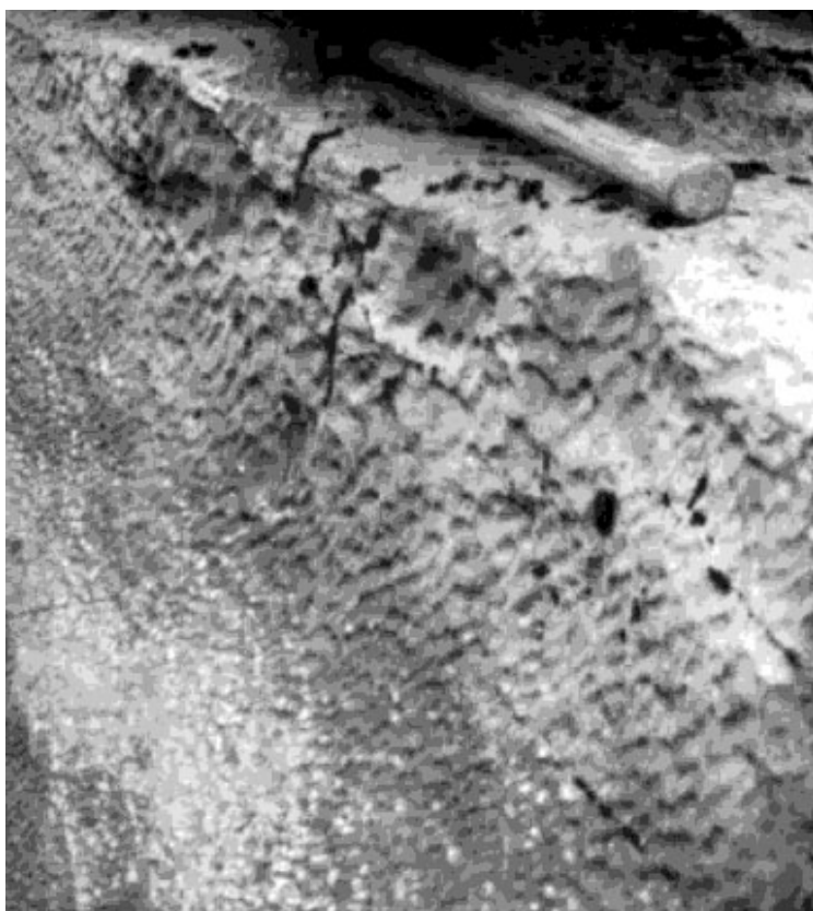
Slika 20. Fotografija korozijskih gubic (Richardson, 1985)
